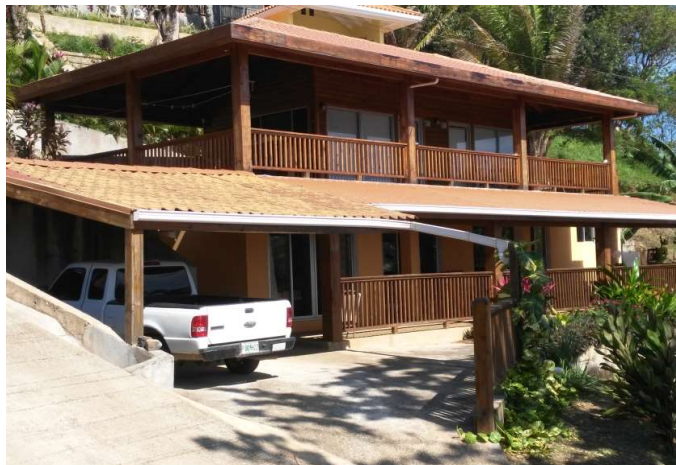
Celkový pohled na dům
