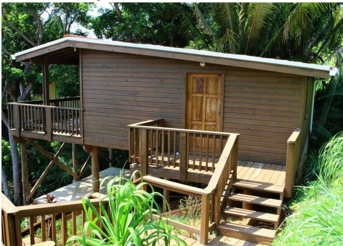
Pohled na vchod
